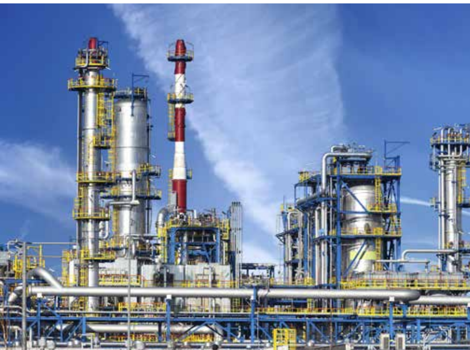
Rohrleitungsanlage, an der die Kiel Montagebau GmbH gearbeitet hat
